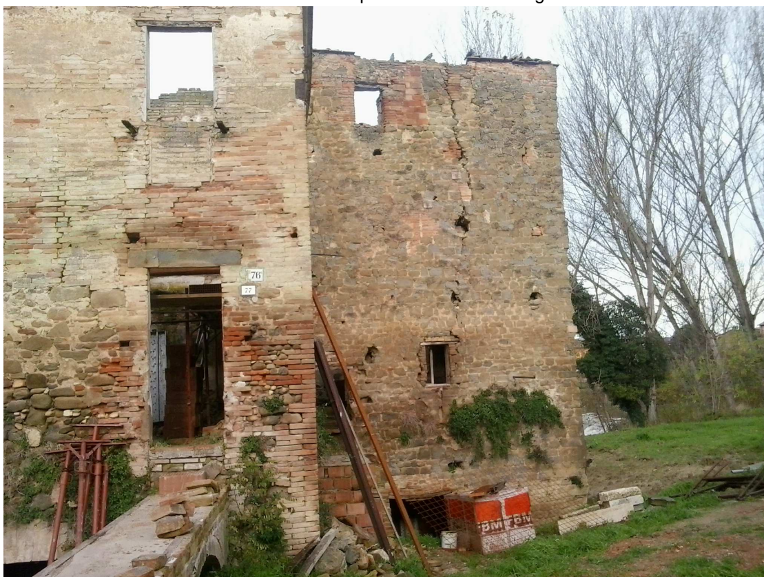
Vista ingresso edificio a monte
