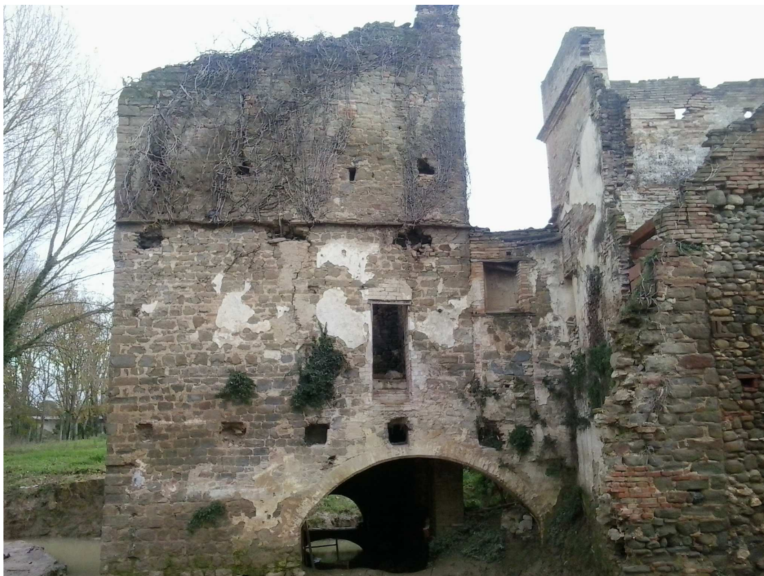
Vista forature solaio e copertura edificio di congiunzione
