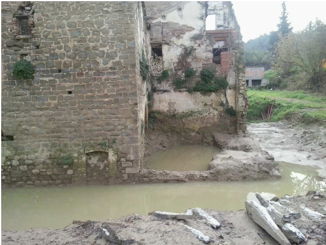
Vista murature edificio di congiunzione
