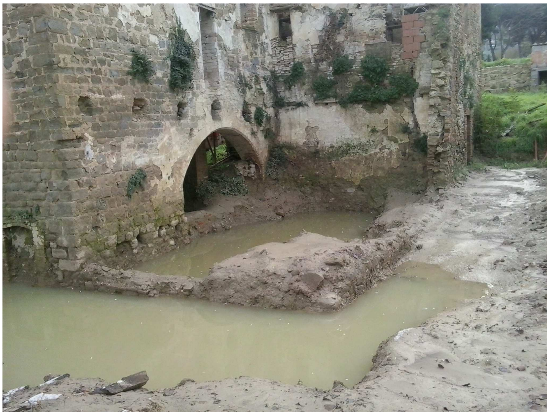
Vista murature edificio di congiunzione
