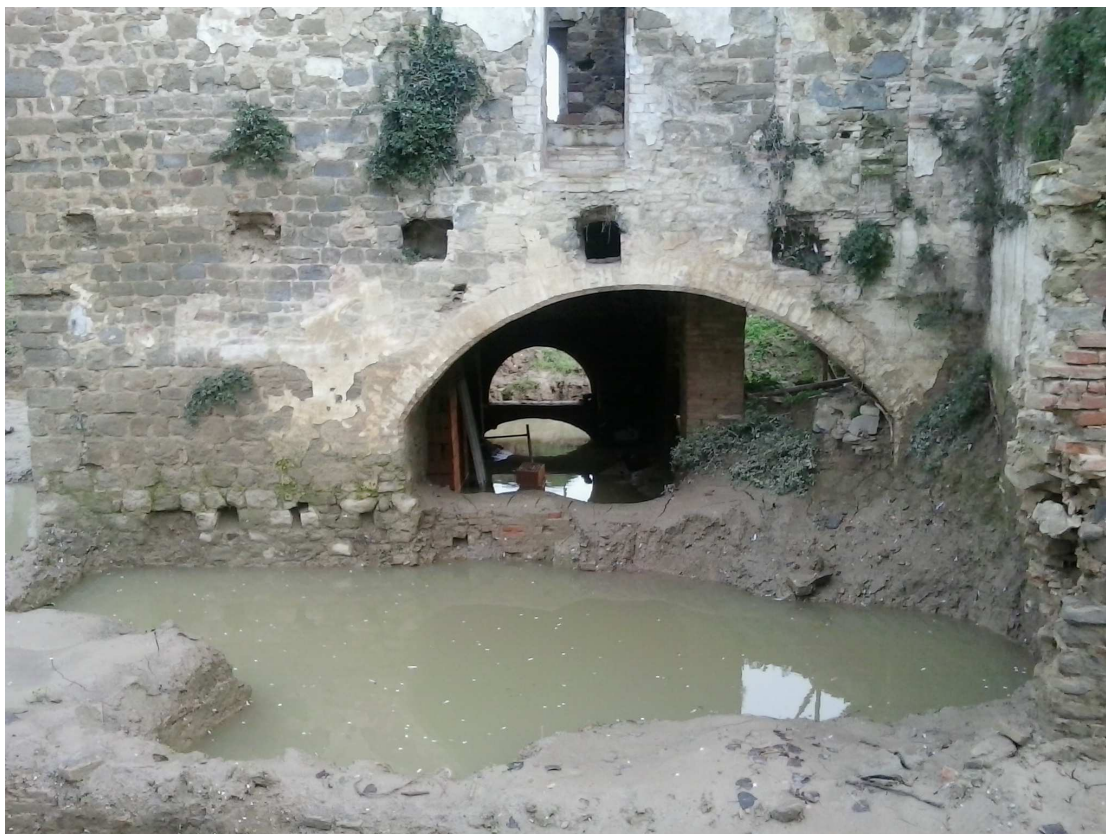
Vista uscita acqua su edificio di congiunzione
