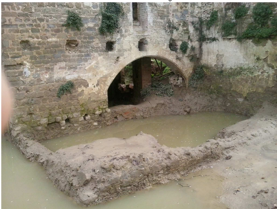
Vista murature edificio di congiunzione
