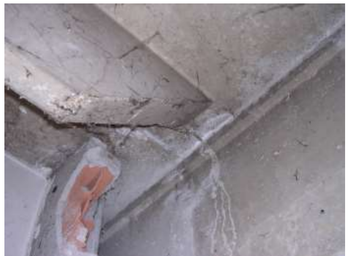
Fig. 2 particolare appoggio coppone/trave
