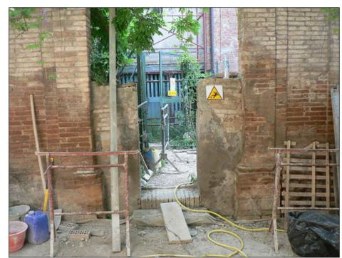
1. demolizione spalle in muratura e scavo terreno
