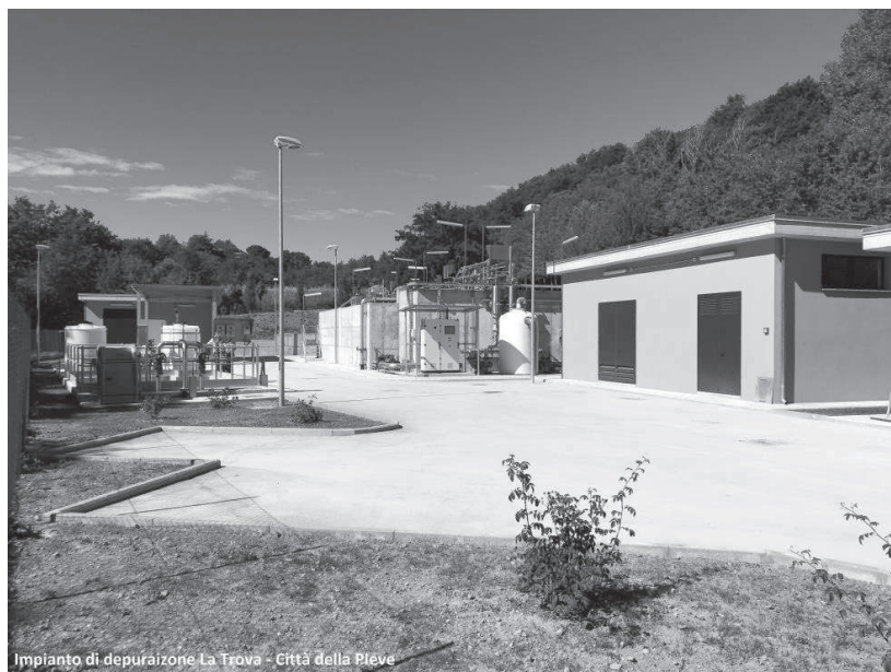
Impianto di depurazione La Trova - Città della Pieve
